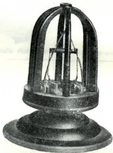
Rys. 14.4.1. Widok ogólny czujki nadmiarowo-topikowej typu Cnt
